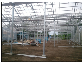
建築中の新温室
